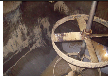
Blick in einen Mischbehälter: Sauber sollte er sein!
